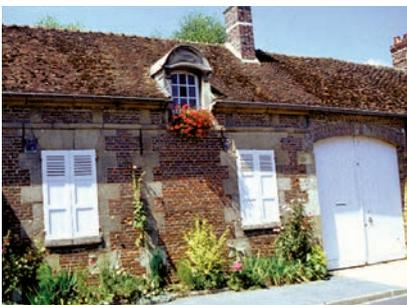
Les murs des maisons en brique et pierre sont appelés murs composites : il s'agit de murs de blocage avec parement de moellons coupés par des cordons de brique stabilisant la maçonnerie. Inversement, il y a aussi des nervures de pierre de taille avec tapisserie en brique. Ces parements nobles sont destinés à rester apparents.
