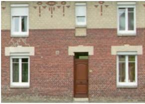
Mur en brique rouge et silico-calcaire
