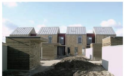
Un volume simple et compact, avec moins de surface de murs extérieurs à isoler, se révèle moins onéreux à la construction. Cela permet de gérer les pertes et apports de chaleur « naturelle » et de maîtriser la consommation d'énergie.
