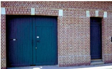
Ravalement de mur de brique, joints à la chaux avec un appareillage panerresse/boutisse, occultation par un store intégré
