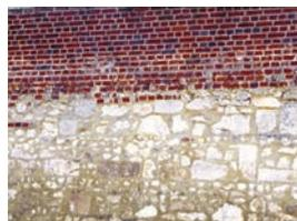
Brique et moellon calcaire
