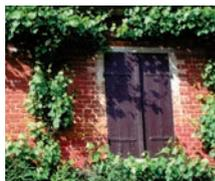
Brique recouverte d'un lait de chaux
