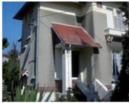
Entrée avec auvent en tuile mécanique
